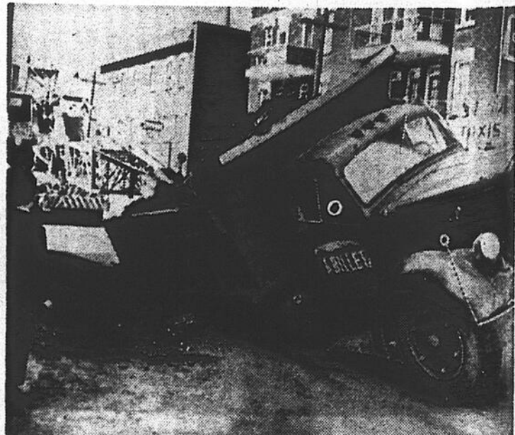
QUAND LE PAVE S'EFFONDRE — A l'angle d'Iberville et de la rue Rachel, un camion s'est soudain trouvé en mauvaise posture, hier après-midi, comme notre photo l'indique. C'est que le pavé a cédé sous les lourdes roues. Il a fallu le touer pour le sortir de là. (Photo "Montréal-Matin", par Claude)
