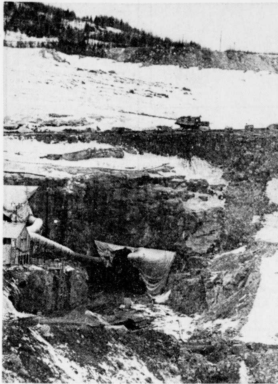
Ce trou dans le roc, c'est la galerie de fuite de la centrale.
