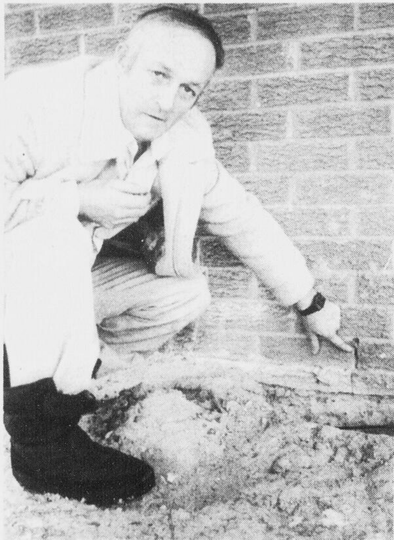
FISSURE - Les fissures, comme celle que Jean-Guy Gagné fait voir ici, sont nombreuses à travers tout le revêtement de briques extérieur de sa maison.
