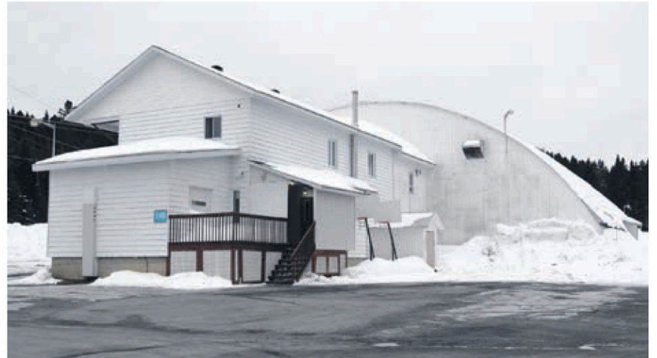
L'actuel Centre sportif Claude-Bédard de Sainte-Justine pourrait être remplacé, d'ici un horizon de deux ans, par un nouveau complexe multifonctionnel au goût du jour et répondant mieux aux besoins de la population. (Photo La Voix du Sud - Serge Lamontagne)
