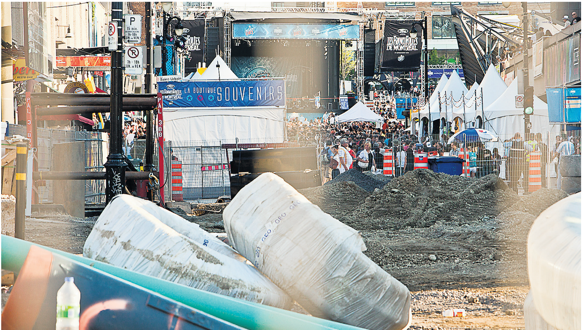
Les travaux de construction sur les lieux des FrancoFolies ont souvent gêné la circulation des festivaliers.
