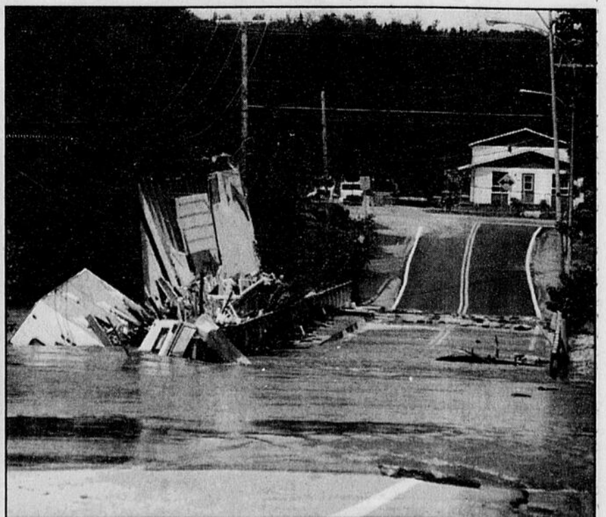
Des pans de murs, des roulottes de camping et des débris de toutes sortes se sont accumulés à l'entrée de ce petit pont de Laterrière, presque immergé par les flots gonflés de la rivière. Le nettoyage sera long et pénible, mais on retrouvera encore longtemps ce type de vestiges des inondations de 1996.
