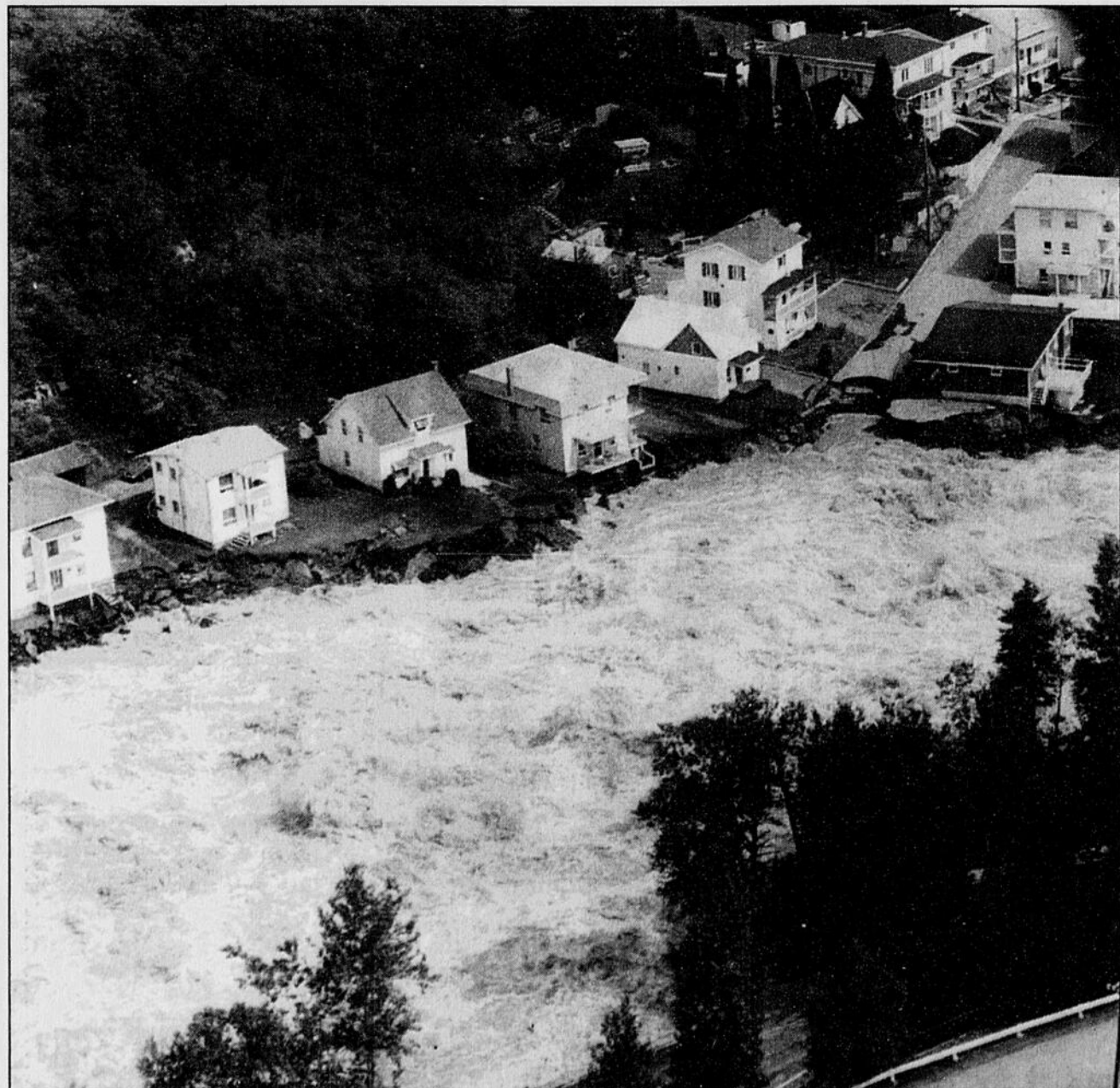
Cette rue a été coupée net par la rivière Chicoutimi, qui a élargi son lit de plusieurs mètres après les pluies torrentielles. Certaines maisons ont basculé dans les flots, d'autres sont restées en sursis sur les bords, en attendant de voir si l'érosion fera son oeuvre.
