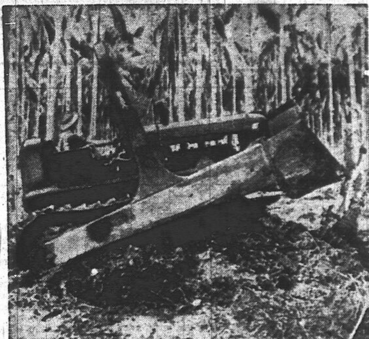
Voici une machine qui sauve bien des maux de tête aux constructeurs de routes. Elle enlève promptement les palmiers à Guadalcanal où l'on veut ouvrir un chemin. Les forestiers mécanisés clairèrent vite le sol.
