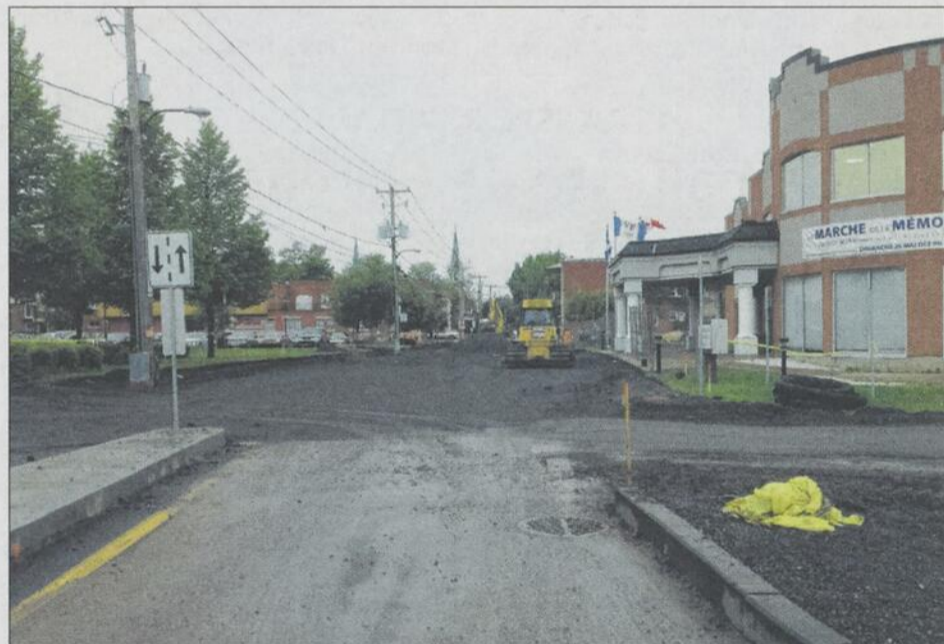
Dans l'entrée sud, les travaux portent sur la reconstruction des infrastructures de la rue Jacques-Cartier, entre les rues Frontenac et Victoria.
