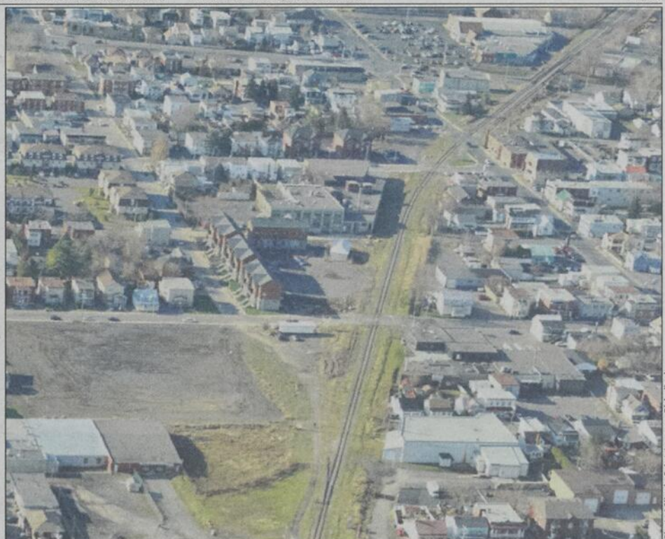
Le projet porte sur le quadrilatère au sud de la voie ferrée, entre les rues Bouthillier et Mercier.
