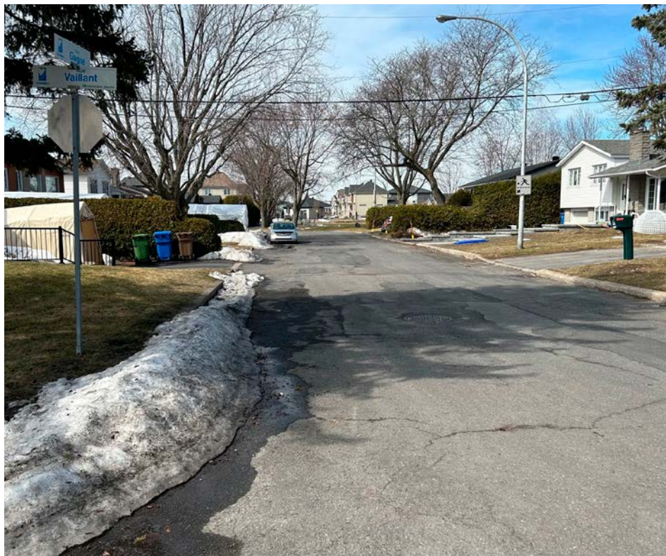
Le chantier sur les deux rues devrait durer quatre mois. (Photo : Julien Dubois)
