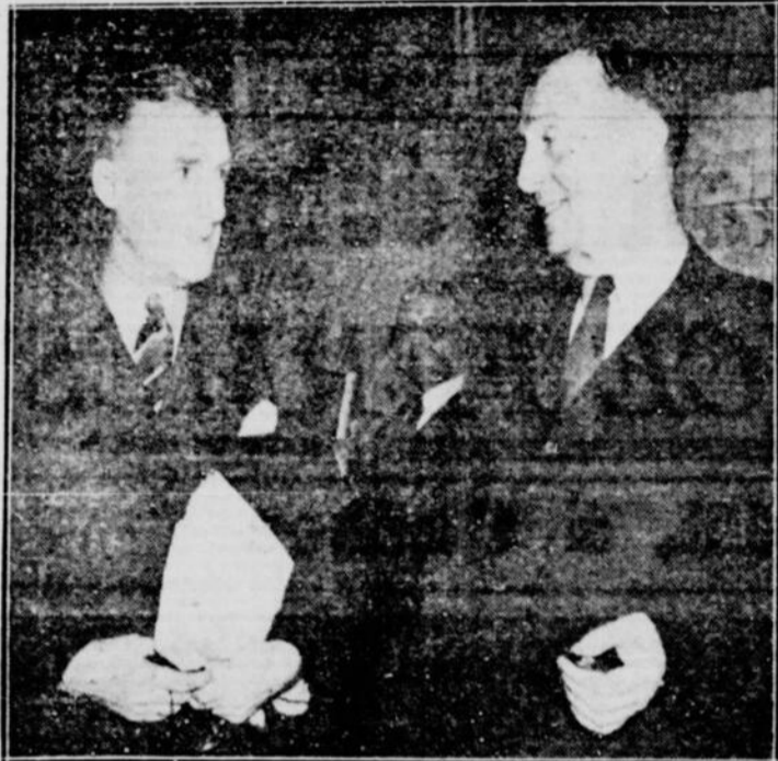
"On ne va pas me réduire ma pension de $5.000 à $3.000" semble demander l'ancien chef des pompiers, M. C. CARSON, à droite, qui cause avec M. W.-R. Bulloch, député de Westmunt, un peu avant la dernière séance d'étude du bill de Montréal, à Québec. (Photo la "Patrie").
