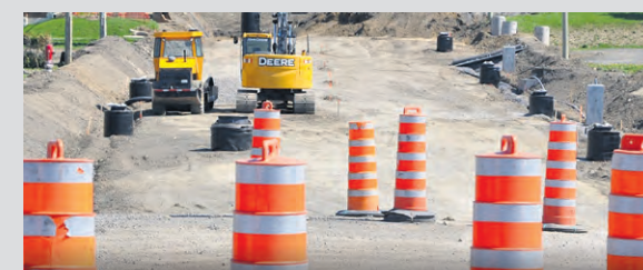
Travaux d'infrastructures sur l'avenue Louise jusqu'en décembre 2023. (Crédit photo : Archives)
