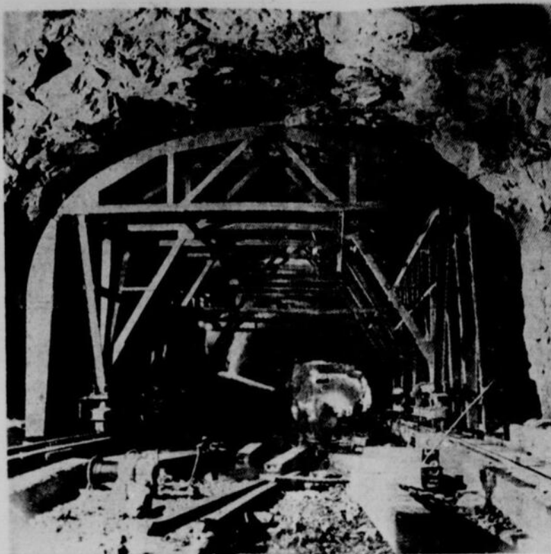
Coffrage mobile pour bétonner le tunnel. Le béton est soufflé à l'extérieur de l'arche. Ensuite, après le séchage, on déplace sur rail cette forme flexible par l'intérieur.
