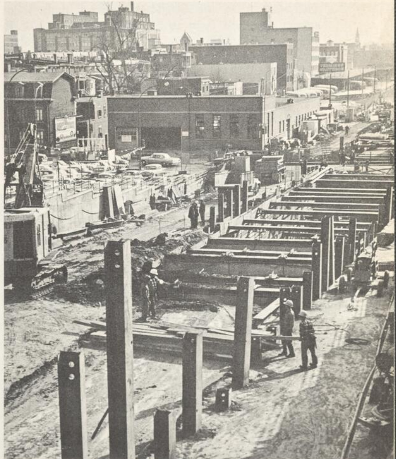
Construction d'une tranchée à ciel ouvert, rue Berri.
