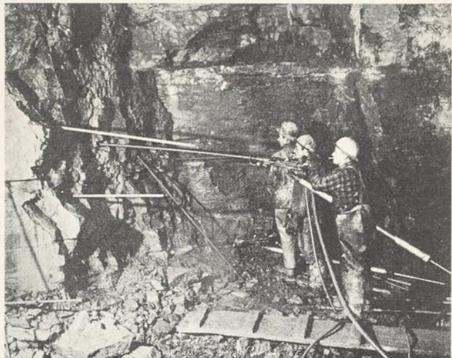
Forage des mines en sous-sol.
