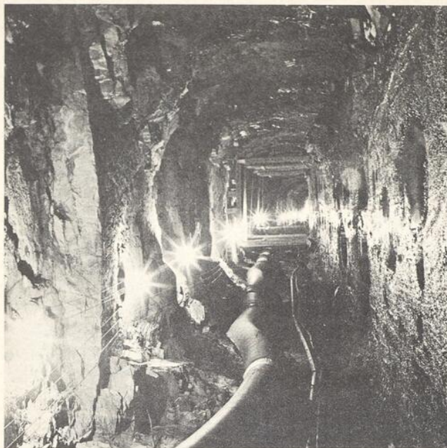
Aspect d'un tunnel en sous-sol creusé dans le roc.
