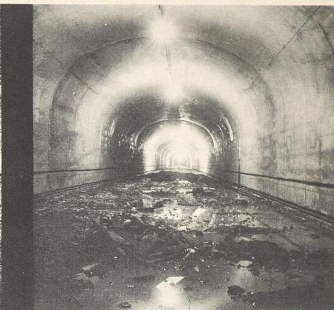
Aspect du même tronçon bétonné.
