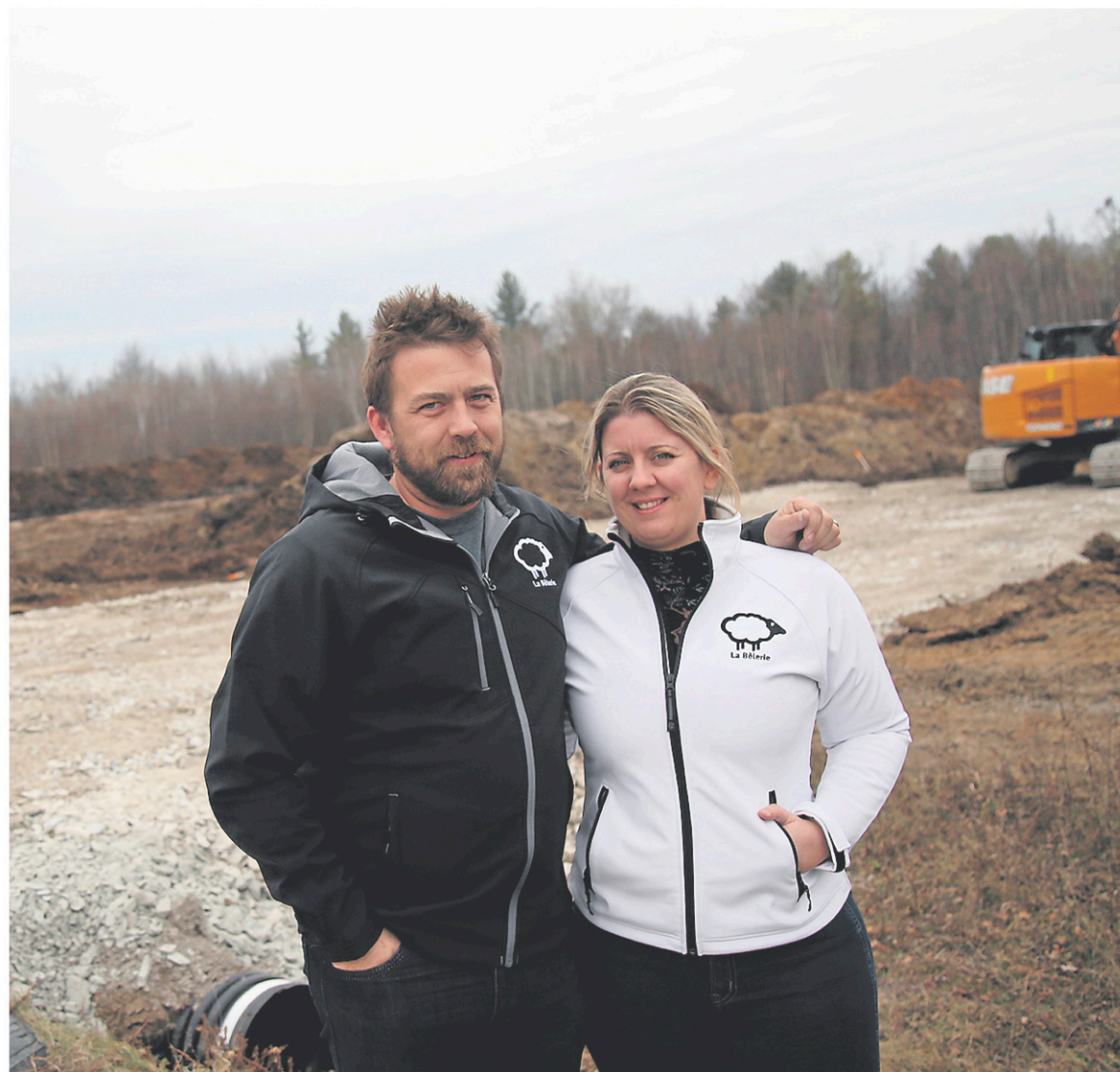
Les travaux ont commencé sur le site du futur Abattoir La Bêlerie, à Cowansville. Un projet de Jamie Schofield et de Myriam Langlois. — PHOTO JULIE CATUDAL
