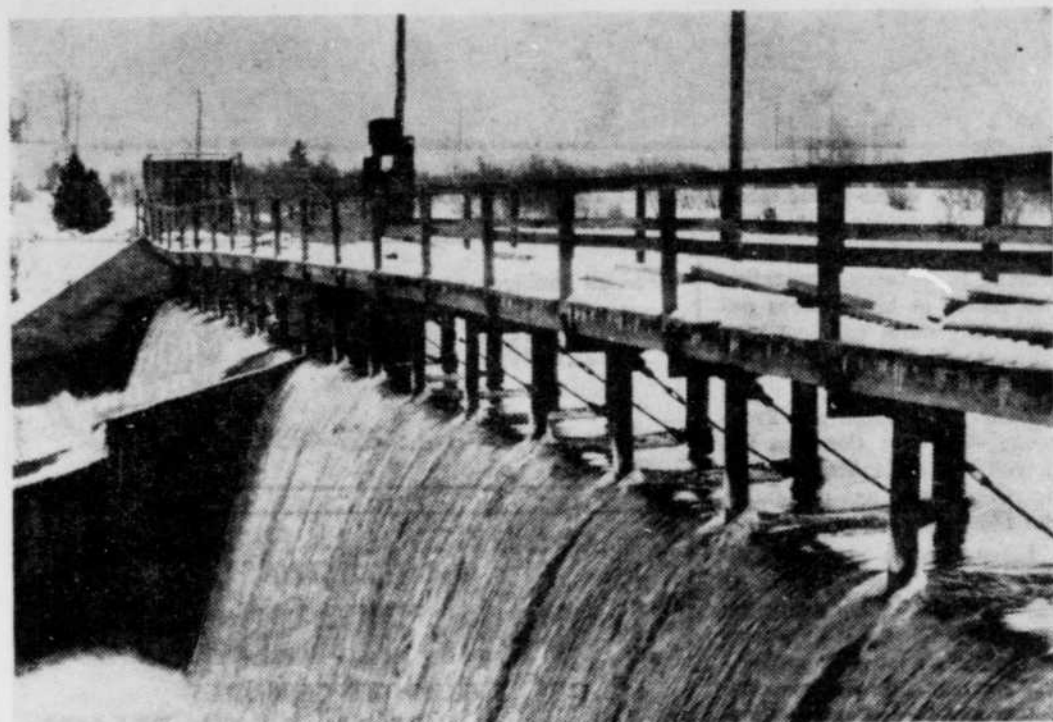
Un barrage qui contrôle le niveau du lac Mégantic...
