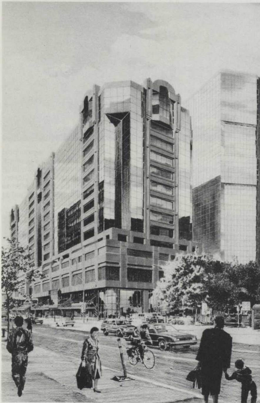
Le futur immeuble "Un Place Alexis Nihon" en construction au coût de 50 millions $ dans le centre-ville de Montréal (Conception d'artiste).
