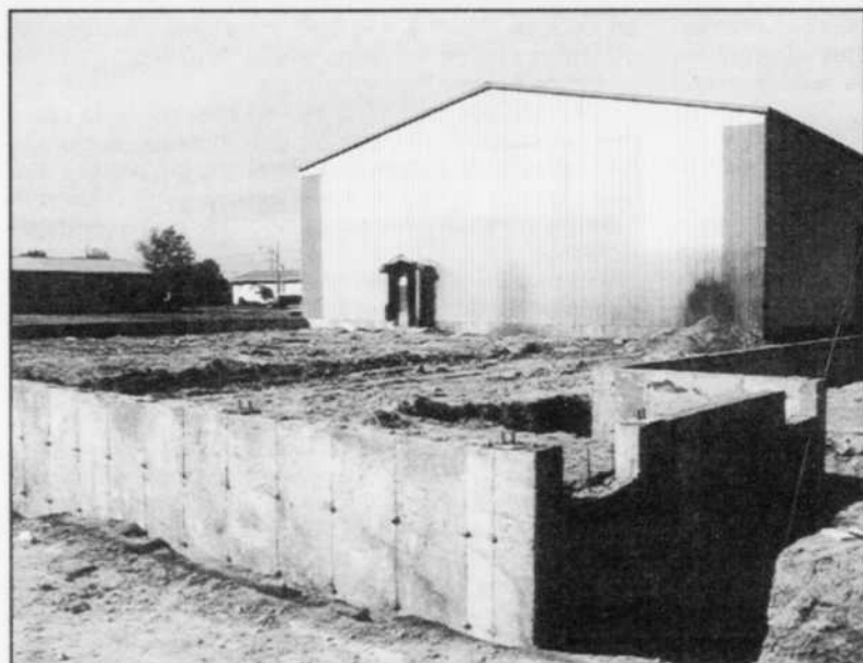
Situé à l'intersection de la route 112 et de la rue Duhamel, tout près de la boulangerie Régale, la nouvelle épicerie de Serge Viens aura une superficie de 12 000 pieds carré
