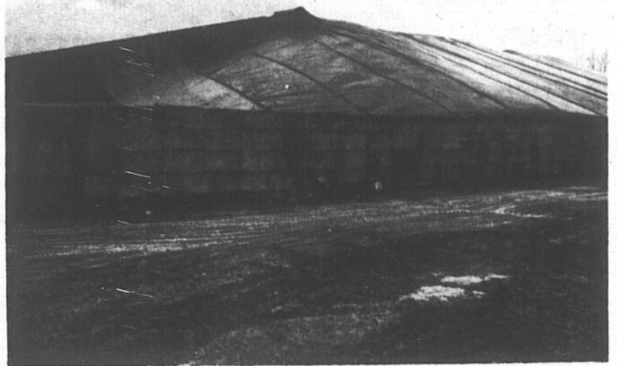
La plate-forme d'une capacité d'entreposage de 15,000 tonnes est entourée de blocs en béton.
