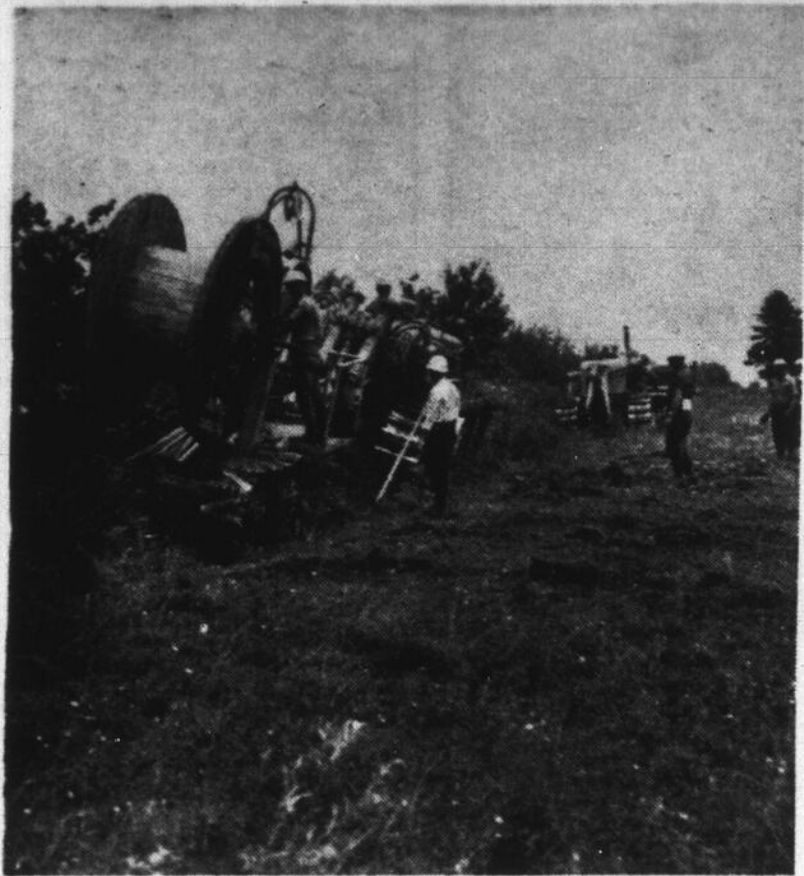
● A CERTAINS MOMENTS, les travailleurs de la compagnie Bell rencontrent des obstacles dans l'enfouissement des câbles téléphoniques. Dans ce cas-ci, il s'agit de rochers qu'il a fallu surmonter. Il a fallu utiliser un second tracteur pour faciliter la tâche de celui qui remorque le fuseau.
