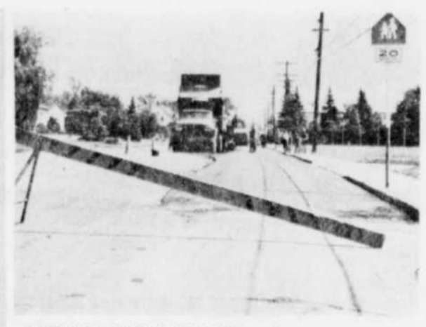
RECouvreMENT D'ASPHALTE. — Des ouvriers du service des travaux publics ont épanché une nouvelle couche d'asphalte, rue Bowen sud, entre les rues Allen et Talbot, à Sherbrooke. Sur cette photo, une équipe d'ouvriers à l'oeuvre.
