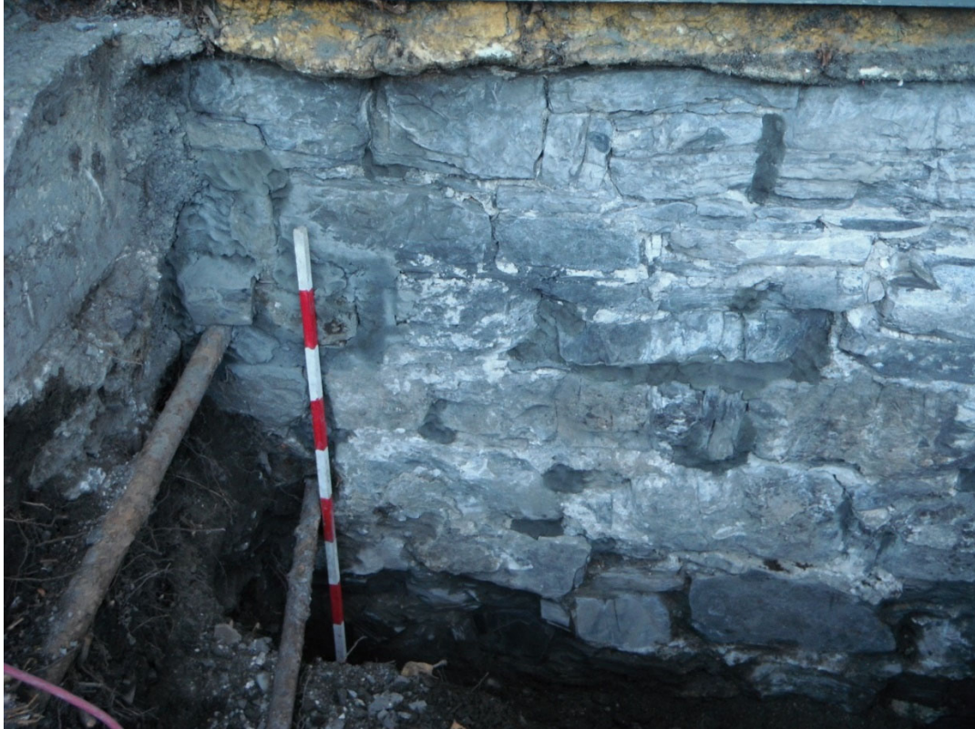
Photo 12 Partie est du mur de fondation 1A100
