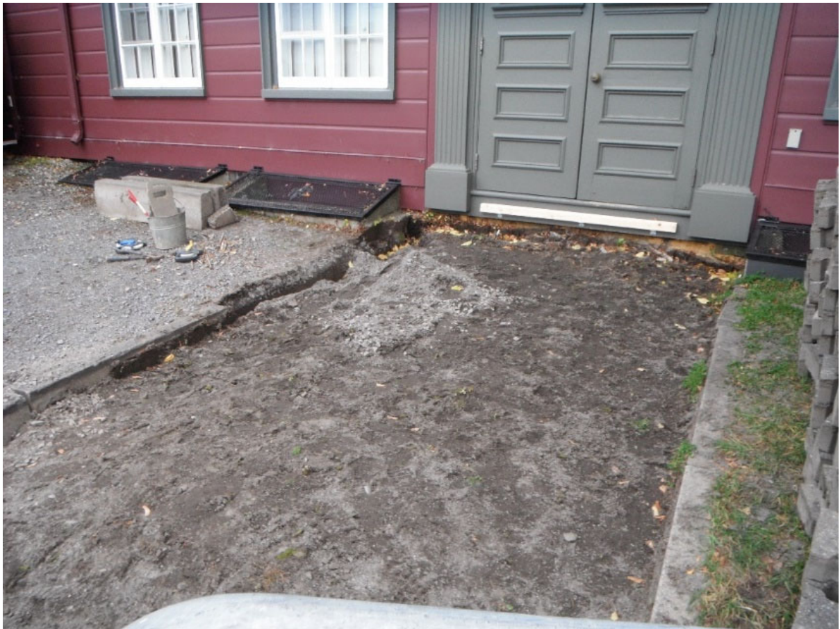
Photo 2 Lit de pose des pavés, vue vers le sud (VDQ2131-21-NUM1-03)
