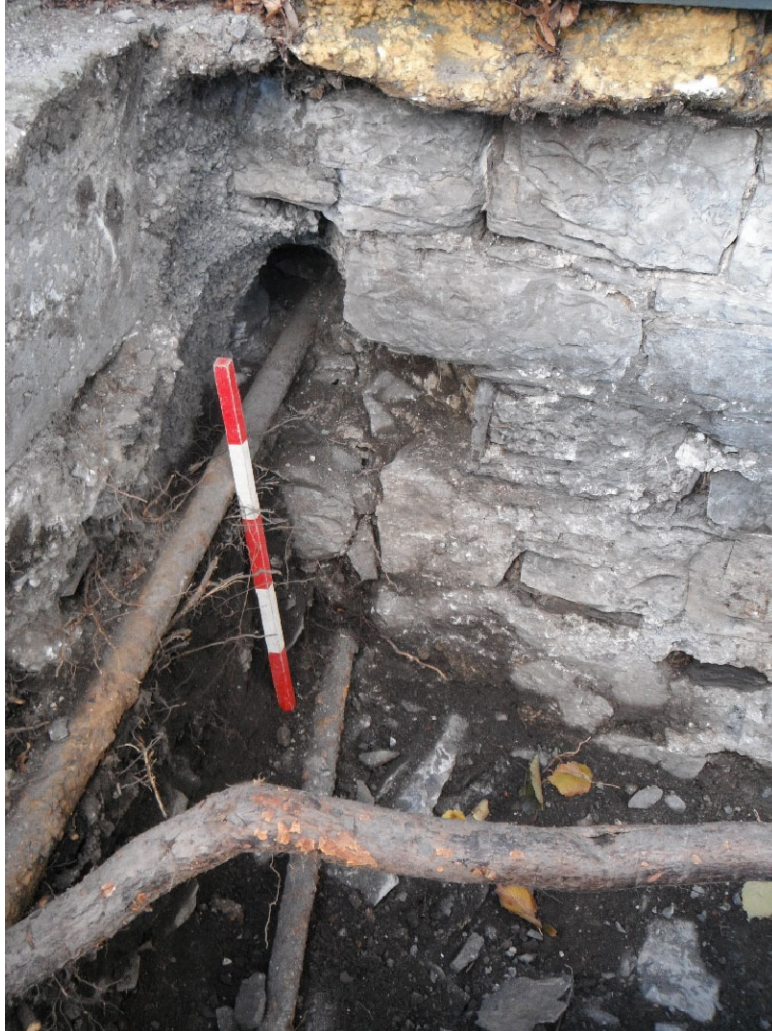
Photo 5 Conduites de métal perçant le mur de fondation, vue vers le sud (VDQ2131-21-NUM1-41)
