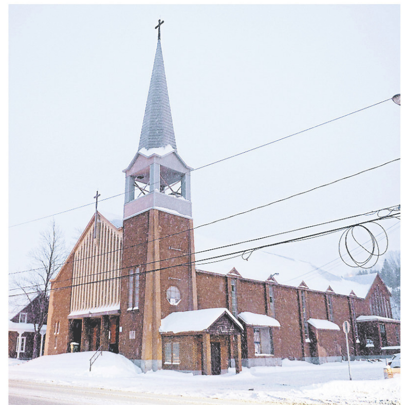
L'église sera démolie pour faire place à un immeuble à logements. — PHOTO LE QUOTIDIEN, JEANNOT LÉVESQUE
