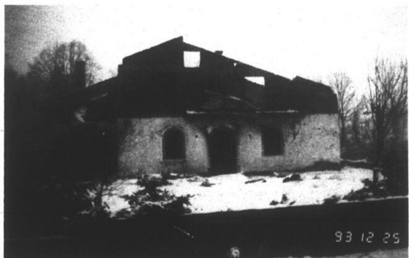
Sur le chemin de Gracak, en Bosnie, l'une des nombreuses maisons détruites lors des confrontations.
