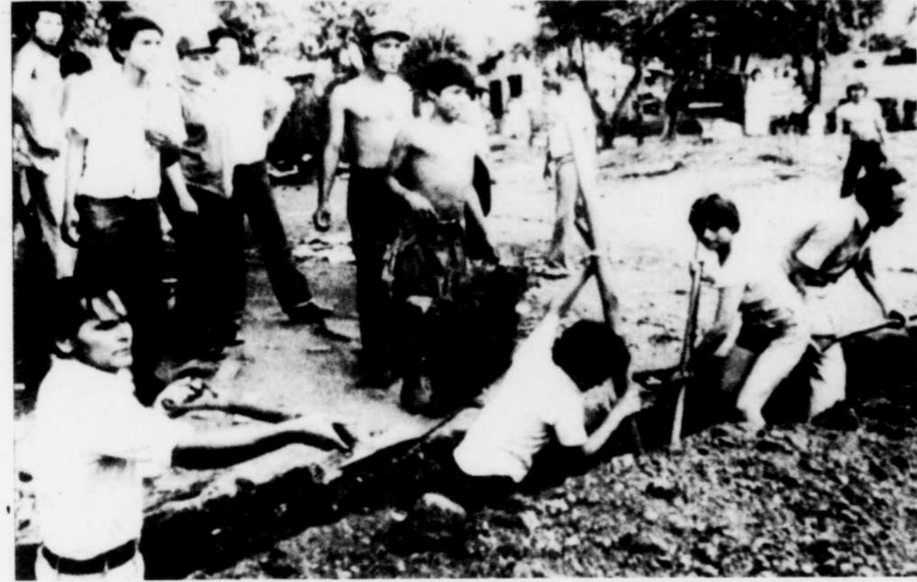
Dans un quartier pauvre de Managua, des jeunes creusent des tranchées en travers d'une rue me-
