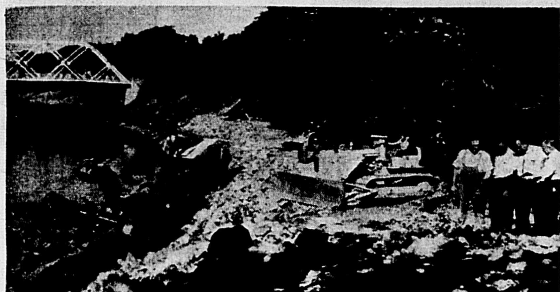
Un aspect des travaux du mur de soutènement, à Saint-Joseph-sur-Yamaska. Ces travaux se poursuivent activement en bordure de la rivière, ayant pour objet de protéger les terrains de nombreux riverains, lors des crues du printemps et de l'automne. Ils furent obtenus du gouvernement d'Ottawa, à la suite de démarches de M. Théo Ricard, député de Saint-Hyacinthe-Bagot aux Communes. (Studio Beluett)
