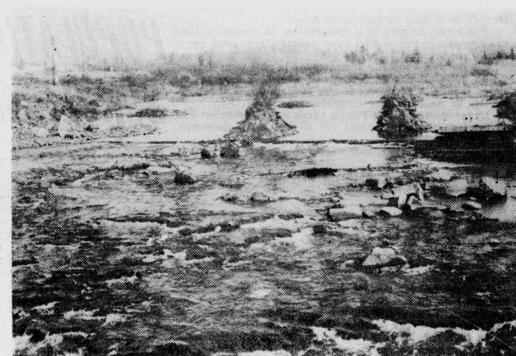
Même si le nettoyage de la rivière aux Saumons, à Scotstown, n'entre pas dans le cadre du projet de Frédéric, ces travaux seront utiles à sa réalisation. (Photo La Tribune)
