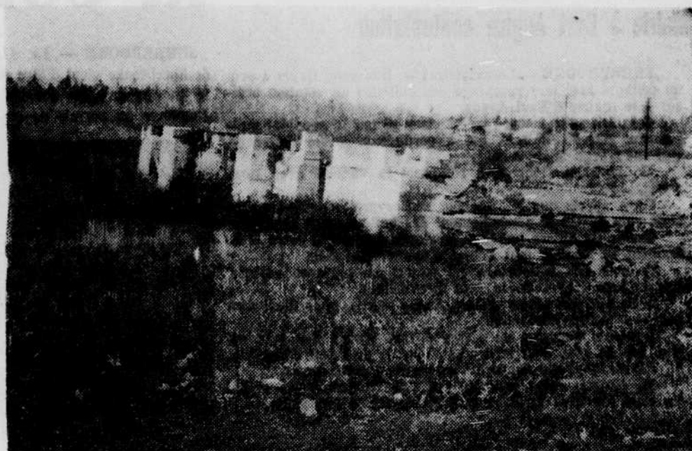
Ces ruines d'une ancienne usine de Scotstown disparaîtront dans le cadre des travaux pour le retour à la vie normale. D'autres travaux précéderont cette phase d'embellissement. (Photo La Tribune)
