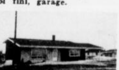
MAISON, 1149, Bizet, 4 ch. salle familiale, salle de lavage, salon, cuisine.
