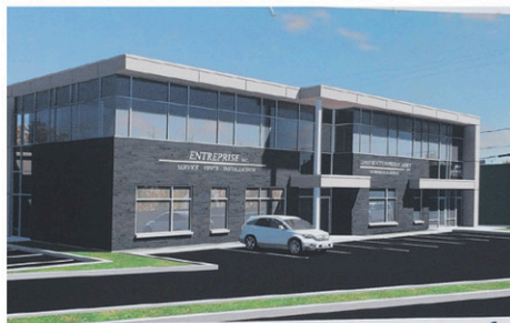
Le bâtiment, une fois les travaux complétés. (Photo: Denis Bélanger)
