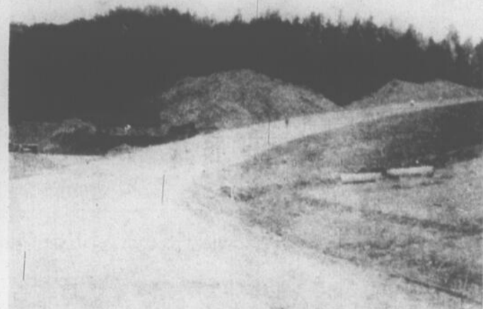
Plus large et réalisée avec une pente plus douce, la voie menant à la nouvelle intersection 161-212 sera ouverte à la circulation dès aujourd'hui. Toutefois, la pose du bitume ne se fera qu'en septembre prochain.
