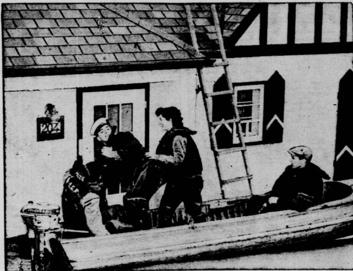
Ce bungalow que des nouveaux mariés avaient payé $8,500 menace ruine. Dix jours d'inondation ont fait gauffer les planchers de bois franc. Les murs sont disloqués et les plafonds s'écroulent. M. et Mme Robinson, du district de Riverview,
