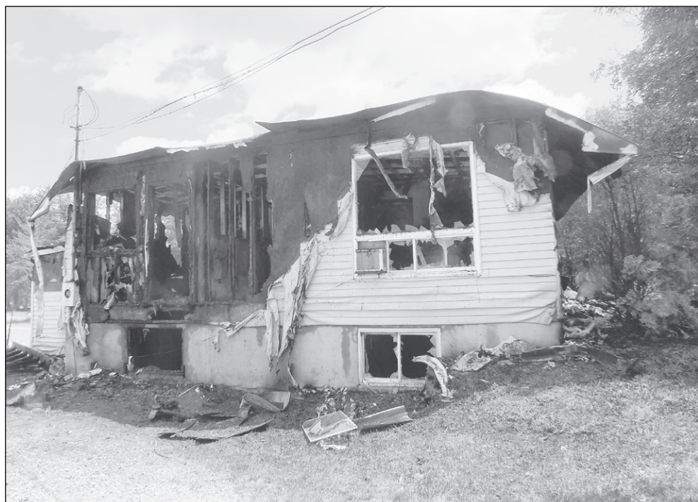
Le bureau administratif a été entièrement détruit par les flammes.
