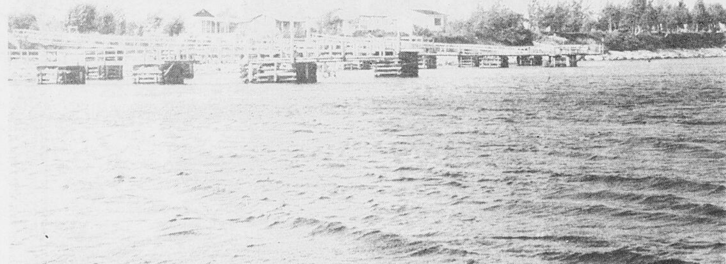
On se croirait vraiment en face d'un aménagement industriel. Pourtant il s'agit tout simplement d'une partie des quelque cinquante quais du genre existant entre Desbiens et Cham-
