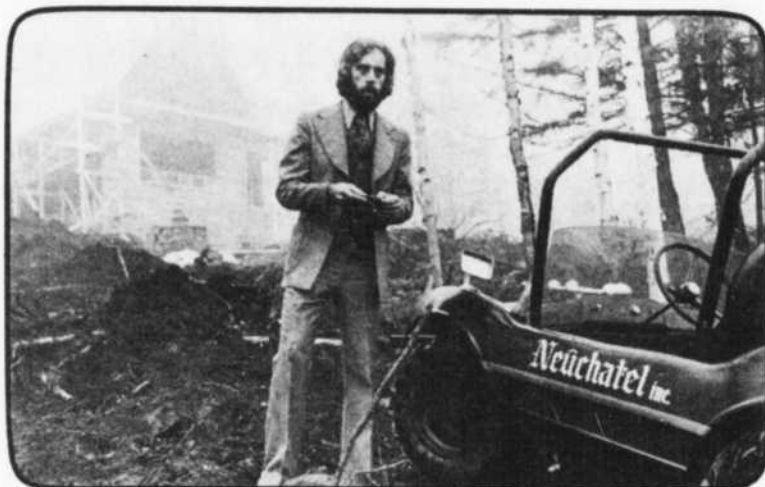
Derrière son "bolide", Mario présente le chalet suisse qui devait devenir le petit nid d'amour de Ginette Reno. Mario regarde cette maison en construction avec beaucoup de nostalgie.
