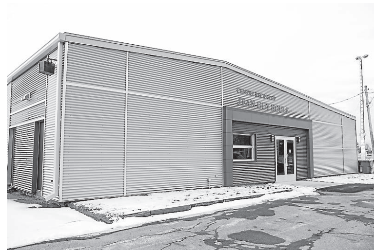
Le Centre récréatif Jean-Guy Houle après les travaux. — PHOTO: OLIVIER CROTEAU
