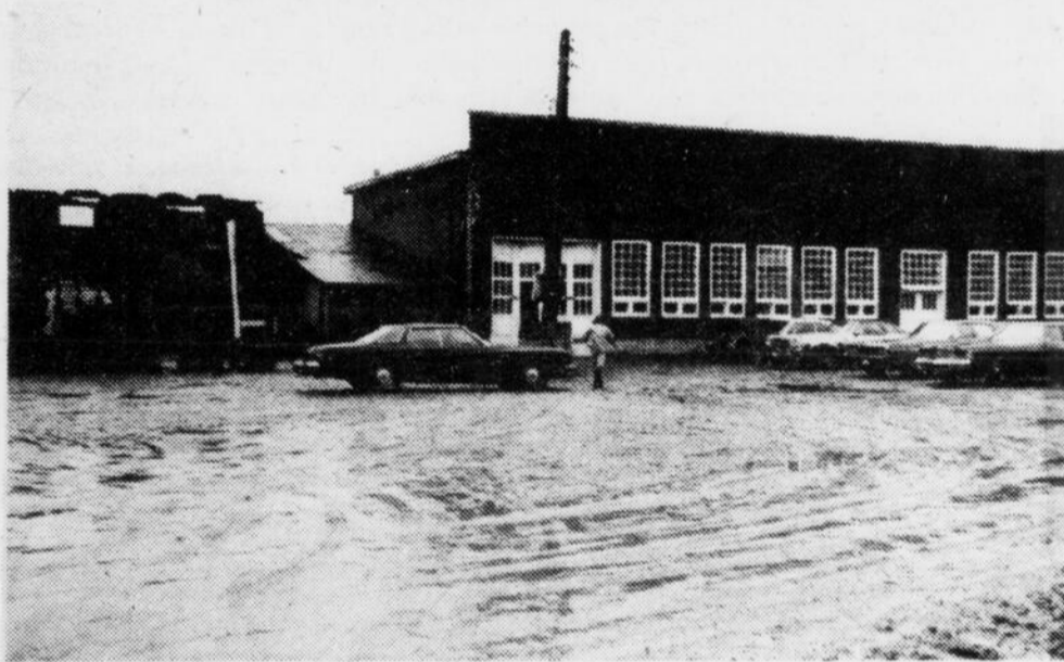
Grâce à leur beau travail, les pompiers ont sauvé le moulin où l'on fabrique les briques.
