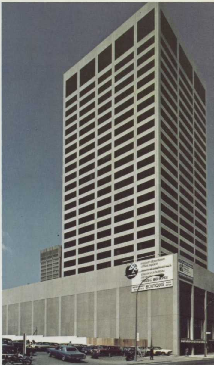
7. Le complexe 2020 Université, une nouvelle tour tout en béton à Montréal.
