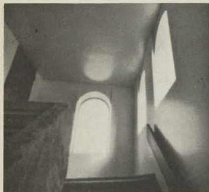
Détail de l'escalier.
