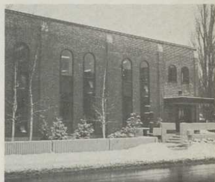
Vue d'ensemble de l'ancienne église aménagée en bureau des architectes Lemay & Leclerc.
