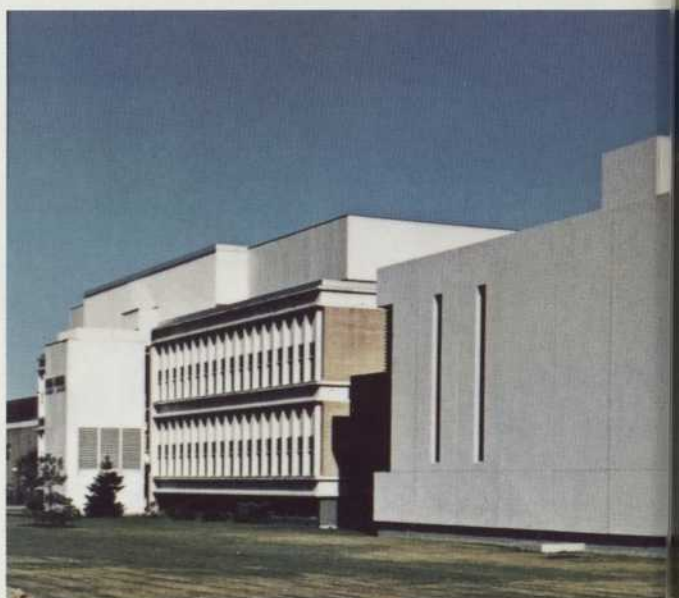
5. Les murs-rideaux en béton confèrent élégance et...
