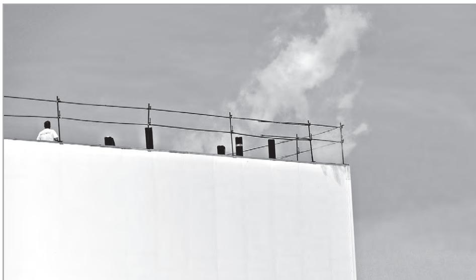
À l'arrivée des pompiers, un léger fumet blanc s'échappait de la structure.
