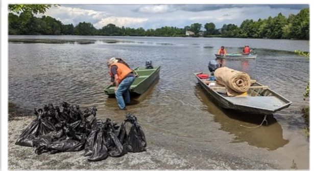
Transport des sacs de lestage et des toiles de jute. Plus de 7000 sacs remplis. Crédit photo CSBVLD.
