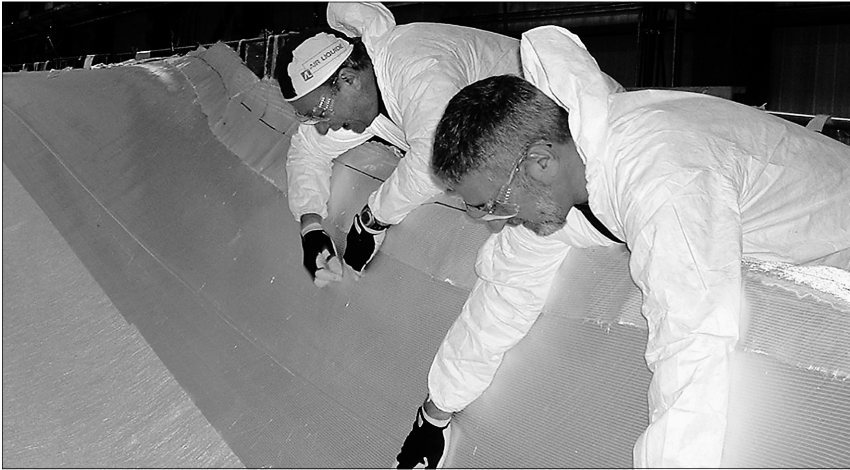
PHOTO HENRI MICHAUD, LE SOLEIL © Les premières pales géantes sortiront de l'usine LM Glasfiber dans les prochains jours. Elles se grefferont aux éoliennes qui seront érigées en Gaspésie d'ici 2011.
