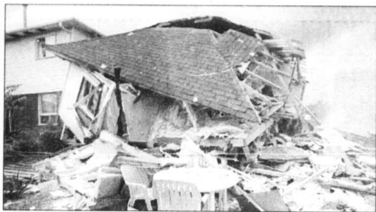
DESTRUCTION - Deux résidences ont été détruites, en banlieue de Toronto, par une puissante explosion d'origine inconnue. (PC - Laserphoto).
