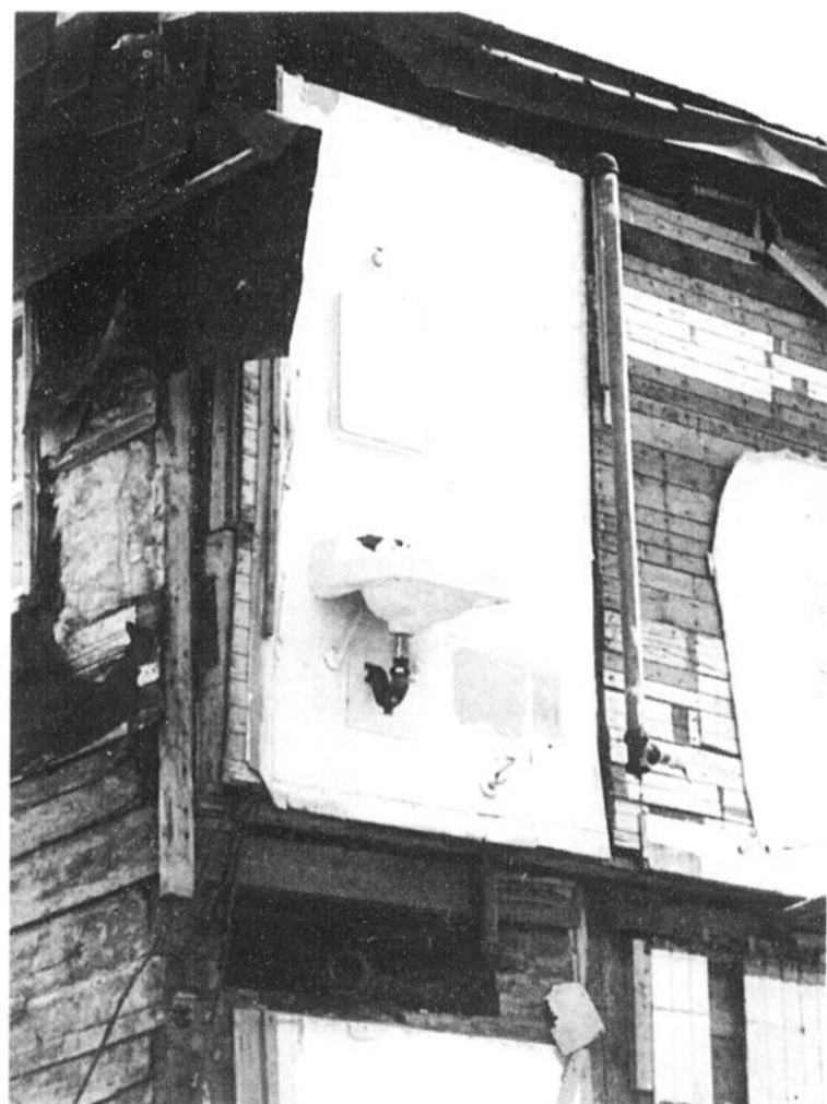
TRANCHE - Le déluge a tranché cette maison comme s'il s'agissait d'une miche de pain, ainsi que l'illustre cette photographie captée près de la rue Bossé, à Chicoutimi. (Photo Rocket Lavoie)
