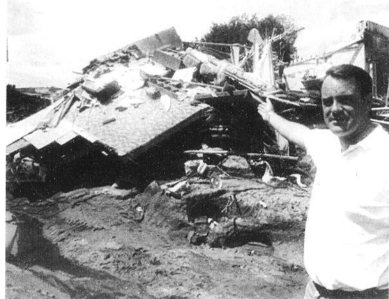
RUINES - Le préventionniste Laval Brassard, de la Sécurité municipale de Chicoutimi, montre les ruines d'un édifice à logements qui a été emporté par l'eau et la boue, dans le quartier du Bassin. (Photo Rocket Lavoie)
