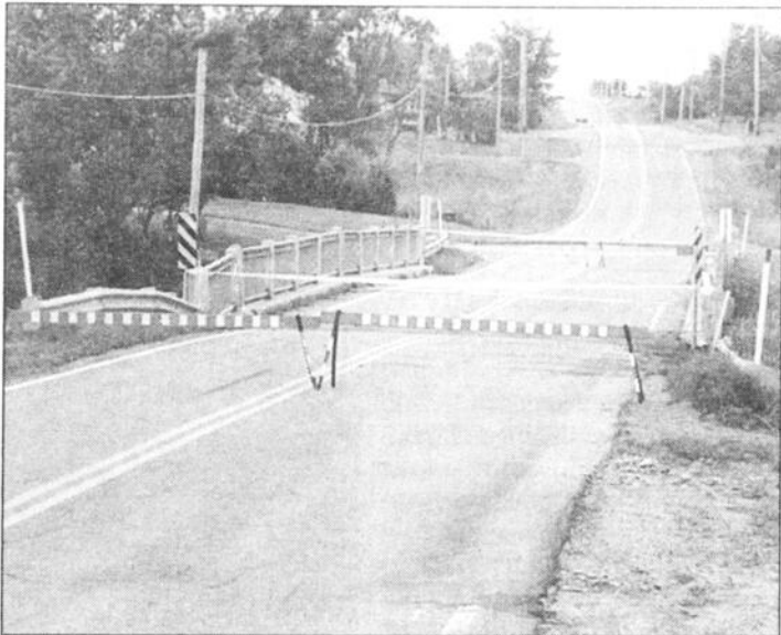
FERMETURE - La route du lac, à Alma, a été fermée à la circulation, hier, à la demande du ministère des Transports du Québec qui devra faire des travaux au pont qui enjambe la rivière Bédard. On s'en doute, c'est une autre conséquence de la pluie qui a frappé la région.
