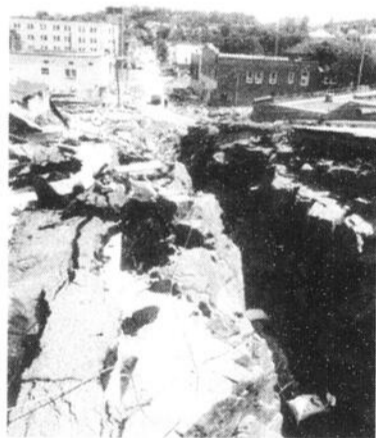
PRISE - Prise en face du Centre Sacré-Coeur, hier après-midi, cette photographie de la rue Bossé donne une idée de la force du courant, qui a tout lessivé sur son passage. (Photo Rocket Lavoie)
