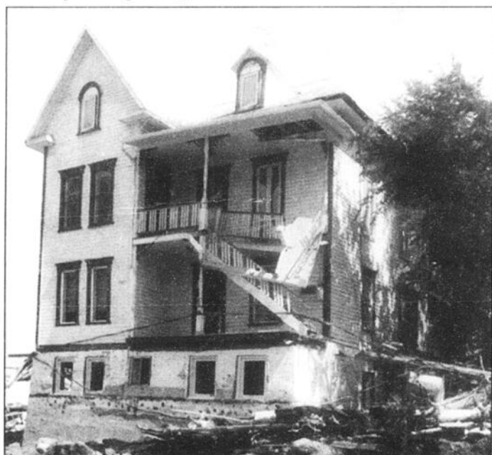
BASSIN - Voilà une maison qui semble avoir résisté au déluge même si l'eau s'est infiltrée un peu partout lors des inondations.
