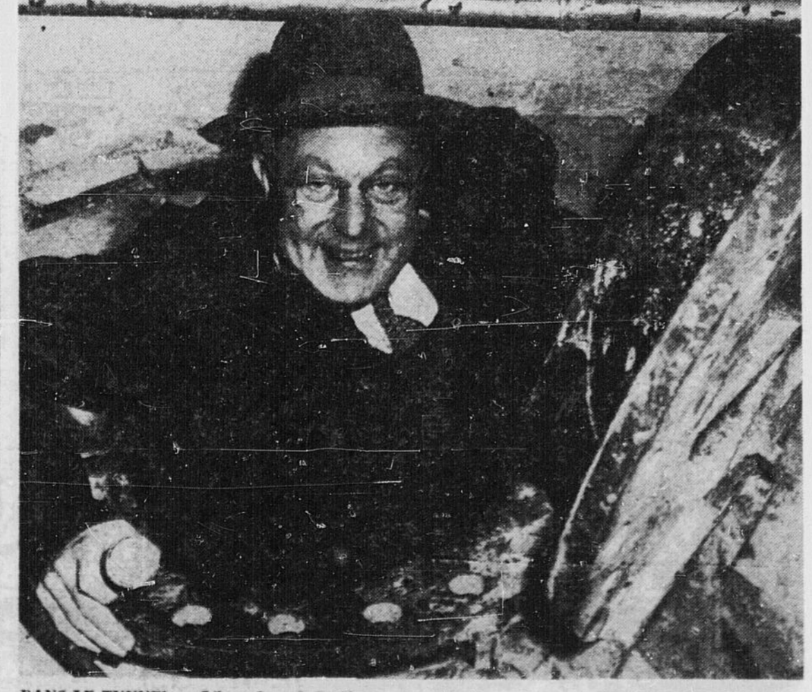
DANS LE TUNNEL — L'hon. Juge J. R. Clyne de la Cour suprême de la Colombie-Britannique descend l'échelle dans un tunnel afin d'examiner les dégâts causés par de formidables éboulements au barrage Whatahan dans les Kootenays. Il dirige l'enquête royale sur le désastre de l'Hydro. (Photo P.C.)
