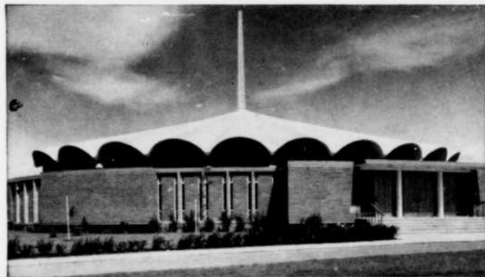
Église Sainte-Trinité, Calgary, Alta. Architectes: Cohos-Delesalle and Associates. Ingénieurs-conseils (structure): Lamb, T. McManus & Assoc. Ltd. Entrepreneur-général: Commonwealth Construction Co. Ltd. Fournisseur de béton préparé: Consolidated Concrete Ltd.
