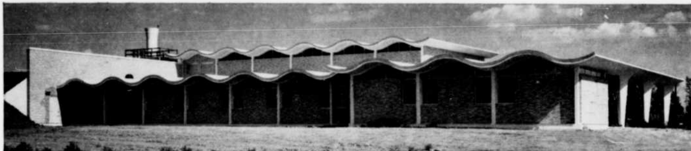
Bâtiment de l'accélérateur de particules atomiques, Université de Saskatchewan, Saskatoon. Architecte: Tinos Kortis. Ingénieurs-conseils (structure): Underwood, McLeish & Associates Ltd. Entrepreneur-général: Poole Construction Co. Ltd. Fournisseur de béton préparé: Stodola Concrete (Sask.) Ltd.
