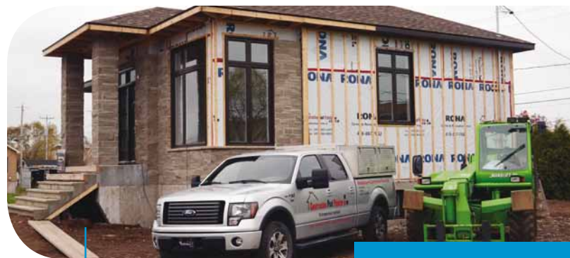
Maison en construction
