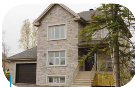
• Construction neuve de deux étages
