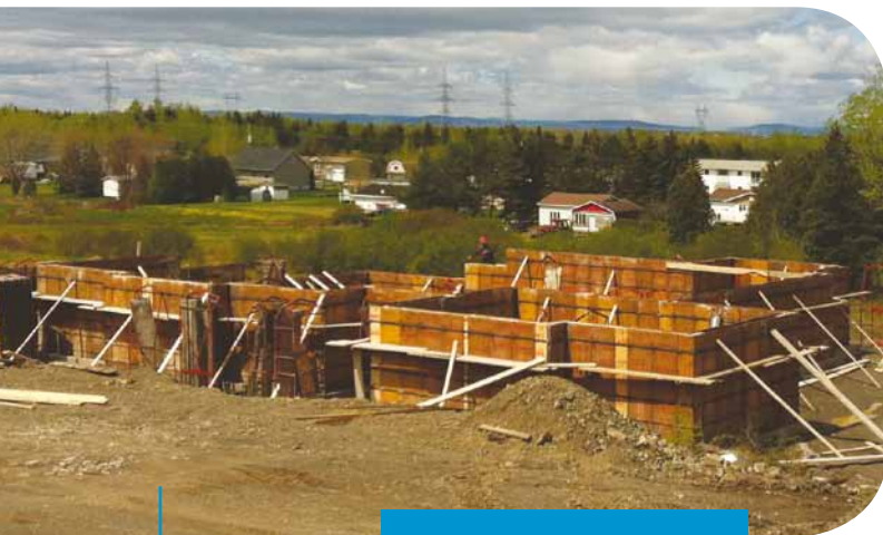
Coffrage en construction
