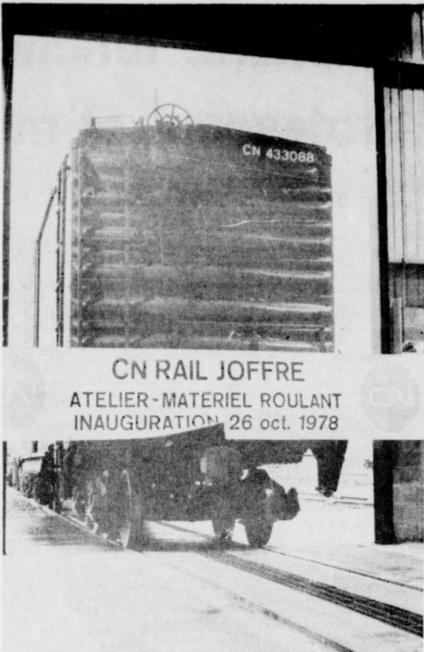
L'entrée spectaculaire d'un wagon marquait le début de l'activité dans le nouvel atelier de réparation du CN.
