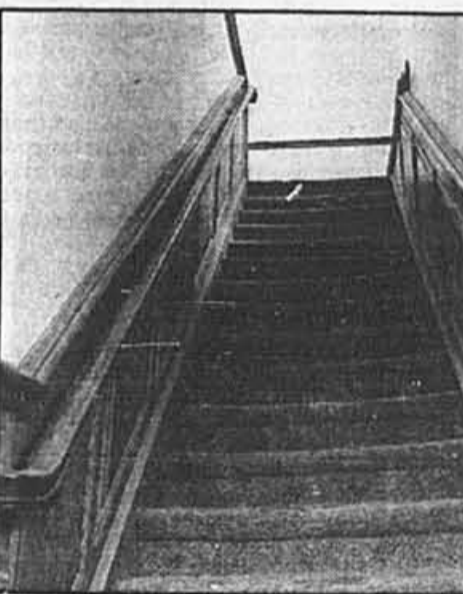
L'escalier en bois conduisant du rez-de-chaussée au premier étage.
