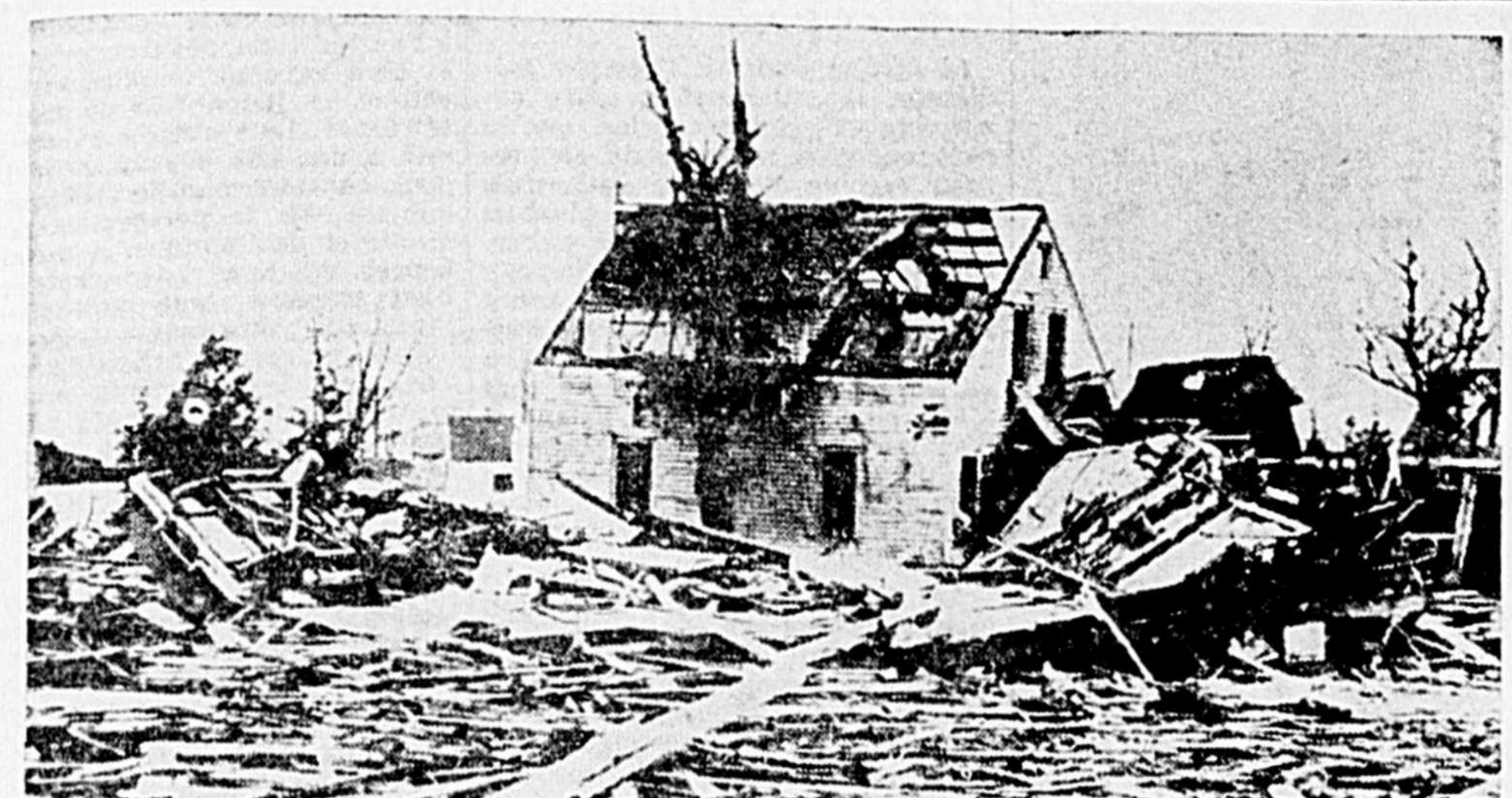
CETTE SCENE DEMONTE L'ETAT LAMENTABLE de Berlin, au Wisconsin, après le passage de la tempête qui a balayé toute la partie nord causant la mort d'environ 38 personnes. Une partie du toit de cette maison a été détruite et une voiture git sous les débris du garage. La tornade a semé la ruine partout où elle a passé. (CPC)
