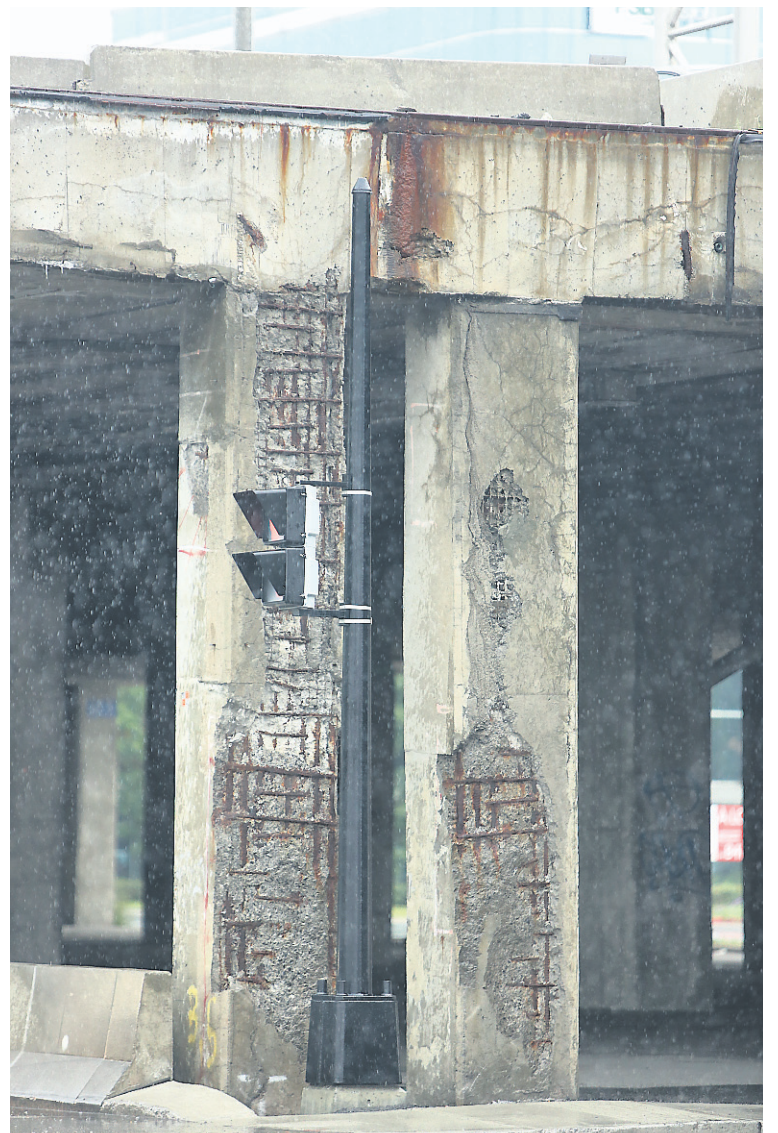
La surface de béton éclaté sur cette colonne de l'avenue Sainte-Croix couvre 30 mètres carrés, selon un rapport d'inspection daté de novembre 2012, où ces dommages étaient déjà consignés.
