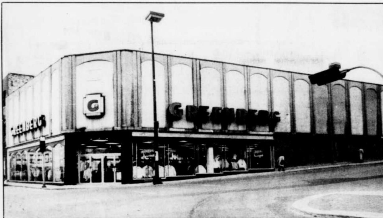
L'immeuble abritant le magasin Greenberg, acquis à la fin de l'année 1986 par l'homme d'affaires Yvon Forcier, recevra une cure de rajeunissement majeure à compter de la semaine prochaine. Un montant d'au moins $80.000 devrait être investi. L'édifice est situé au coin des rues des Forges et Royale, au centre-ville de Trois-Rivières. (Flageol Photo — Roméo Flageol)
