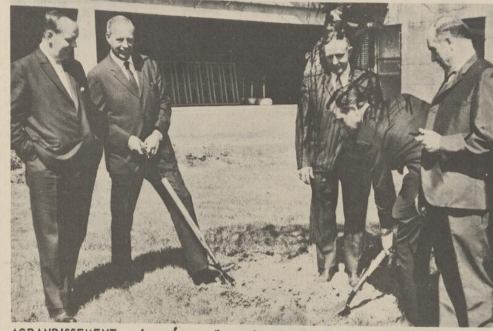
AGRANDISSEMENT -- Les travaux d'agrandissement de l'Hôpital de Saint-Jean ont débuté hier matin, en présence du député provincial, M. Jérôme Proulx et des autorités médicales de l'hôpital local. Cet agrandissement servira à la clinique externe et aussi à la clinique d'urgence. C'est la firme Omer Brault qui a obtenu le contrat de construction au coût de $169,800. Nous reconnaissons sur la photo, de gauche à droite: le Dr Jean-Marie Côté, directeur général de l'hôpital Saint-Jean; M. Harold Savoy, vice-président de la Corporation de l'Hôpital Saint-Jean; M. Omer Brault, contracteur; M. Jérôme Proulx, député, levant la première pelle de terre et le Dr. Vial Lavoie, président du Bureau médical et président de la Corporation du futur Hôpital du Haut-Richelieu.
