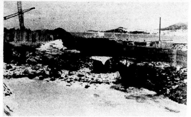
La cale sèche de Les Méchins est en bonne voie.
