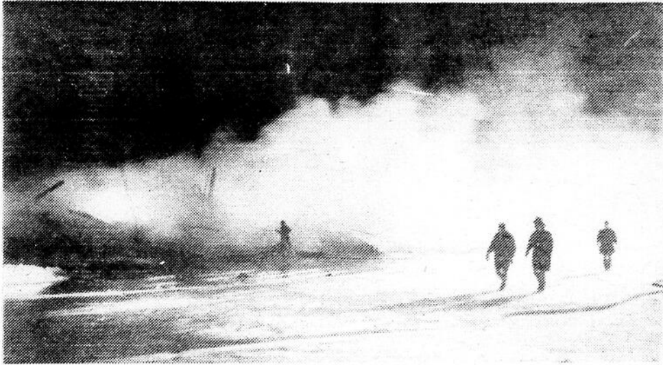
On peut se rendre compte que l'édifice qui servait d'entrepôt a été complètement rasé par le feu. La bâtisse renfermait un équipement souvent fort coûteux. [Photo Progrès-Echo]
